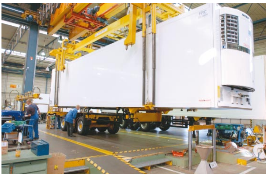
3. ábra: az önhordó hűtőfelépítmény és a rövid segédalváz összeszerelése
